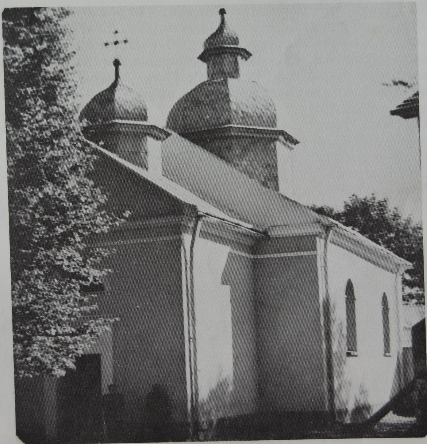
Церква св. Параскевії в Кабарівцях, збудована 1836 р.
